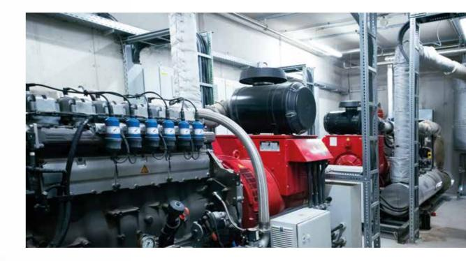
BGA 136 ETA 150 KW<sub>el</sub> - 265 KW<sub>el</sub>
